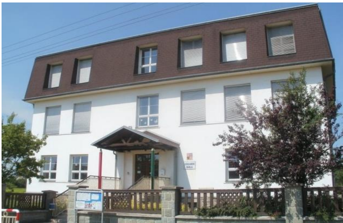
ZŠ Skřipov, kotelna na pelety
